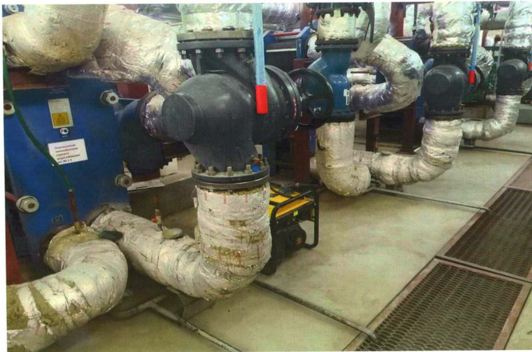
Теплообменник ГВС, 1-я ступень, пластинчатый
