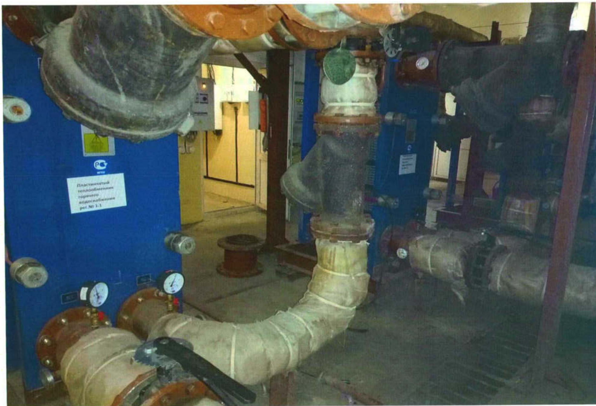
Теплообменник ГВС, 1-я ступень, пластинчатый M15-MFG, Альфа-лаваль
