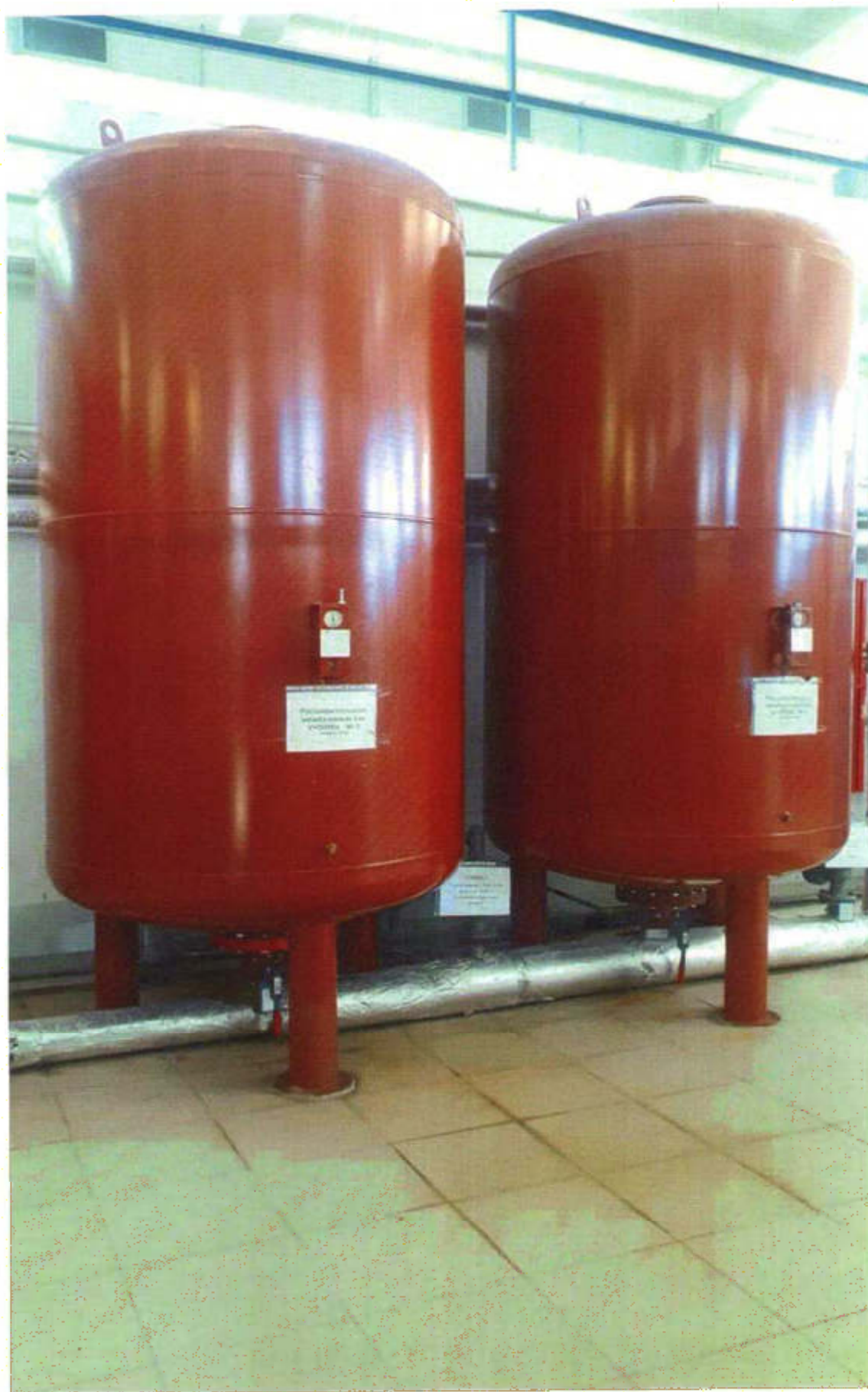
Расширительный мембранный бак сетевого контура Reflex G5000
