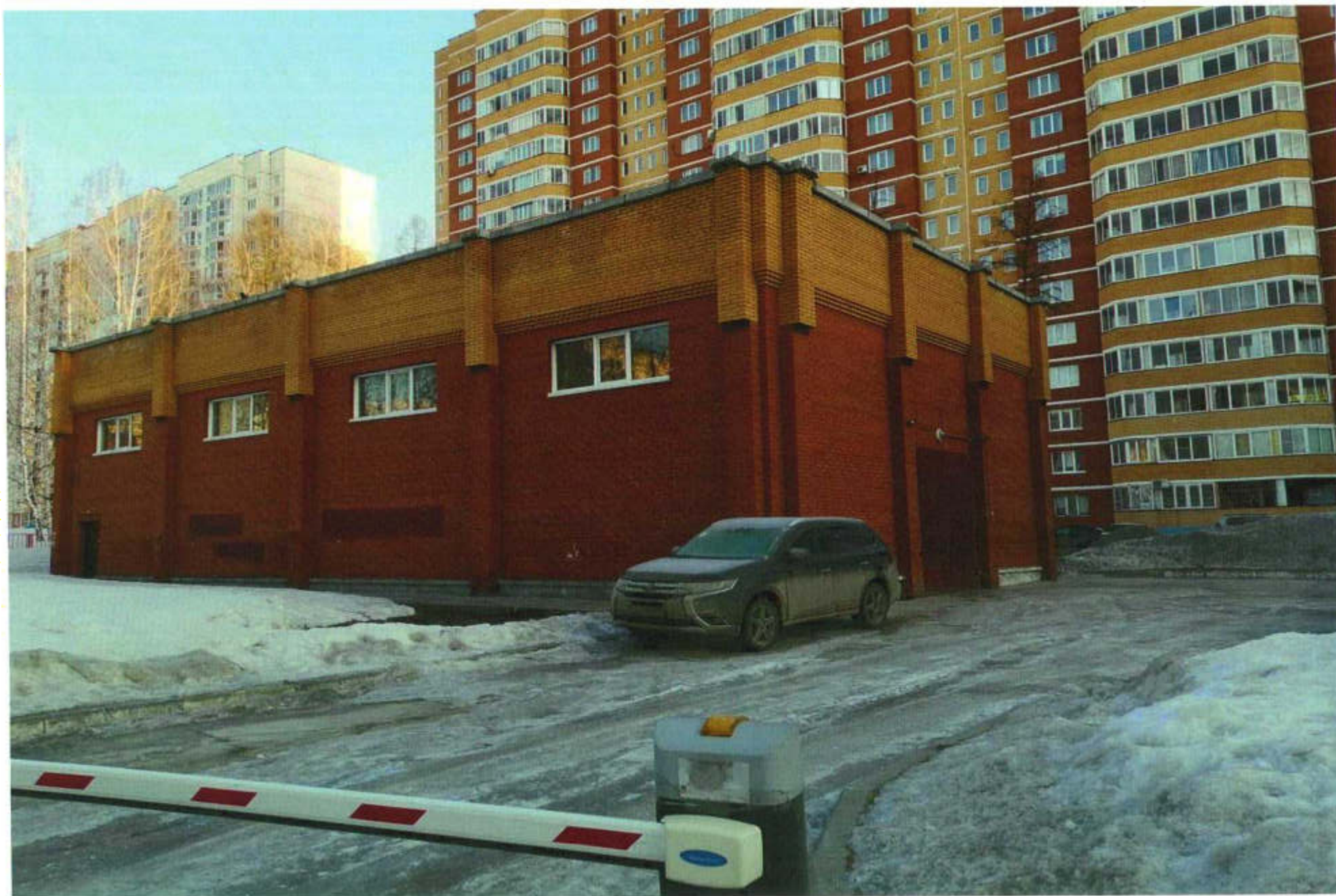
Центральный тепловой пункт (стр.№355) по ул.Свечникова
