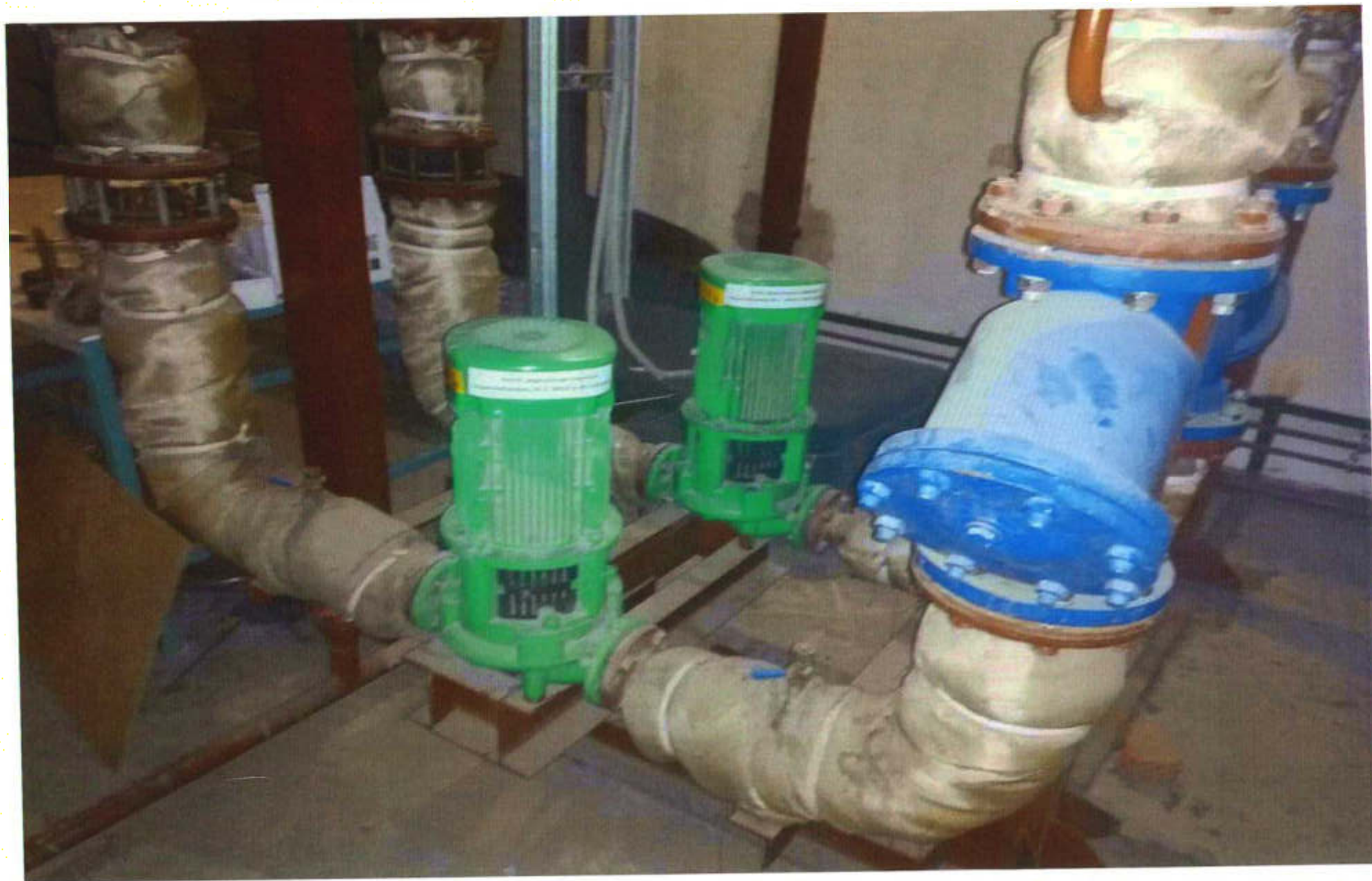
Насос циркуляционный ГВС с частотным преобразователем WILO IL40/160-4/2
