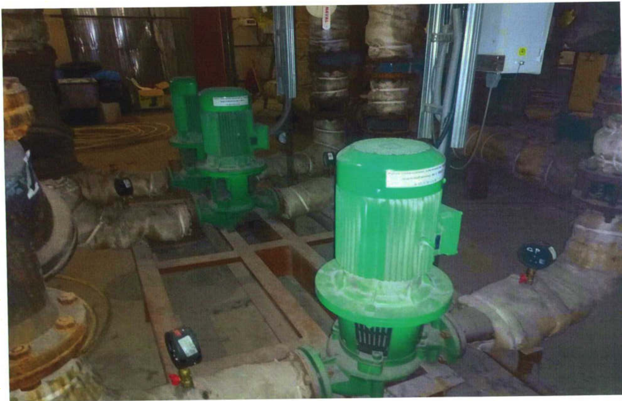
Насос повысительный для системы ГВС с частотным преобразователем П 65/170-11/2 WIL0
