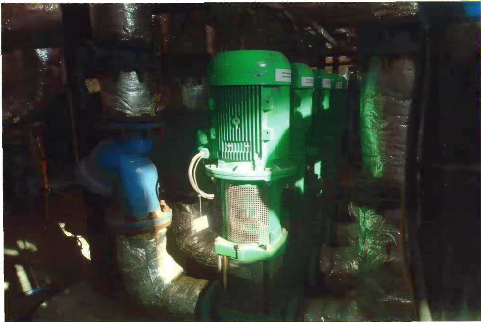
Насос повышения давления ГВС с частотным преобразователем MVI 5204 WILO
