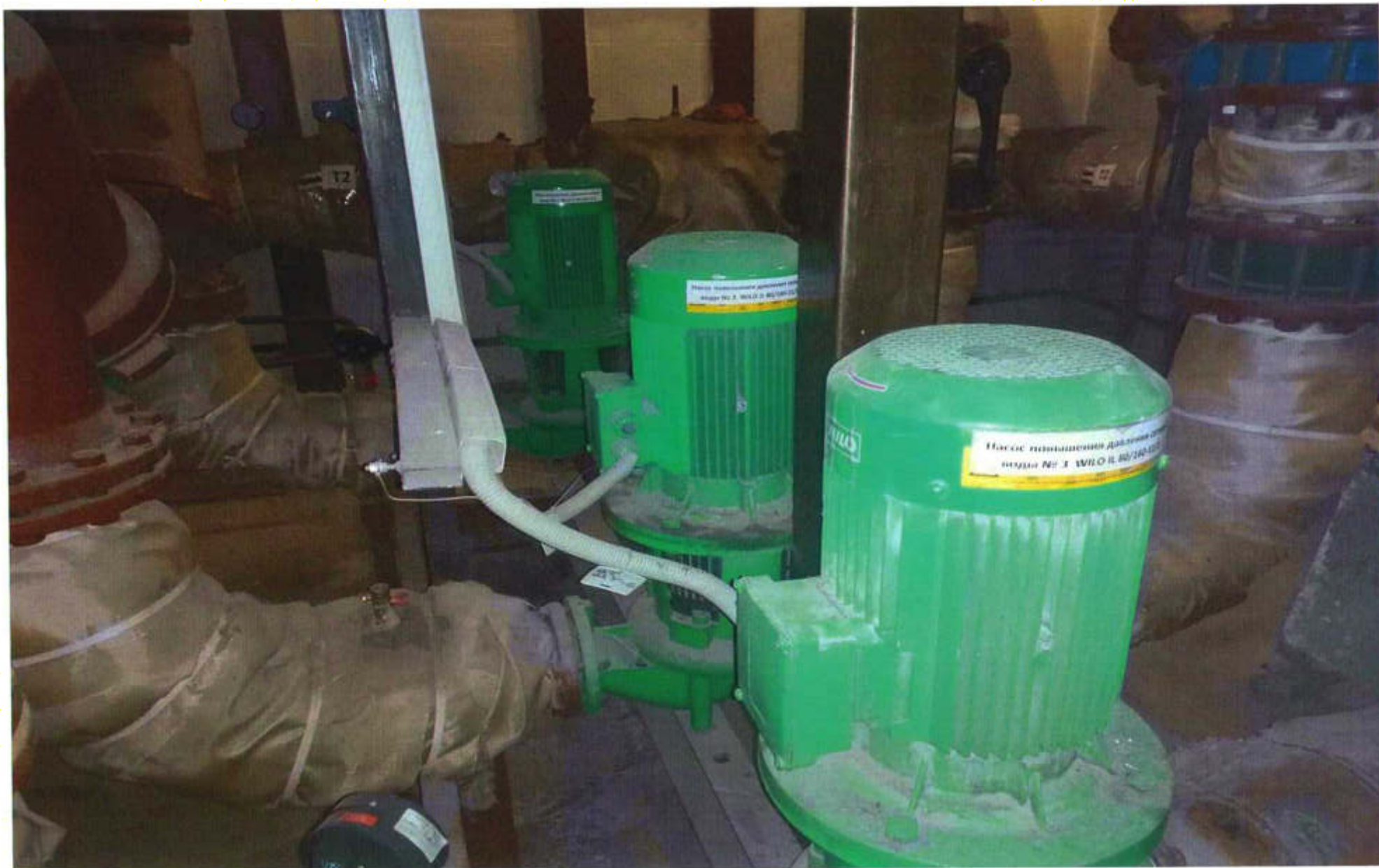
Насос понизительный с частотным регулированием IL80/160-11/2 WIL0
