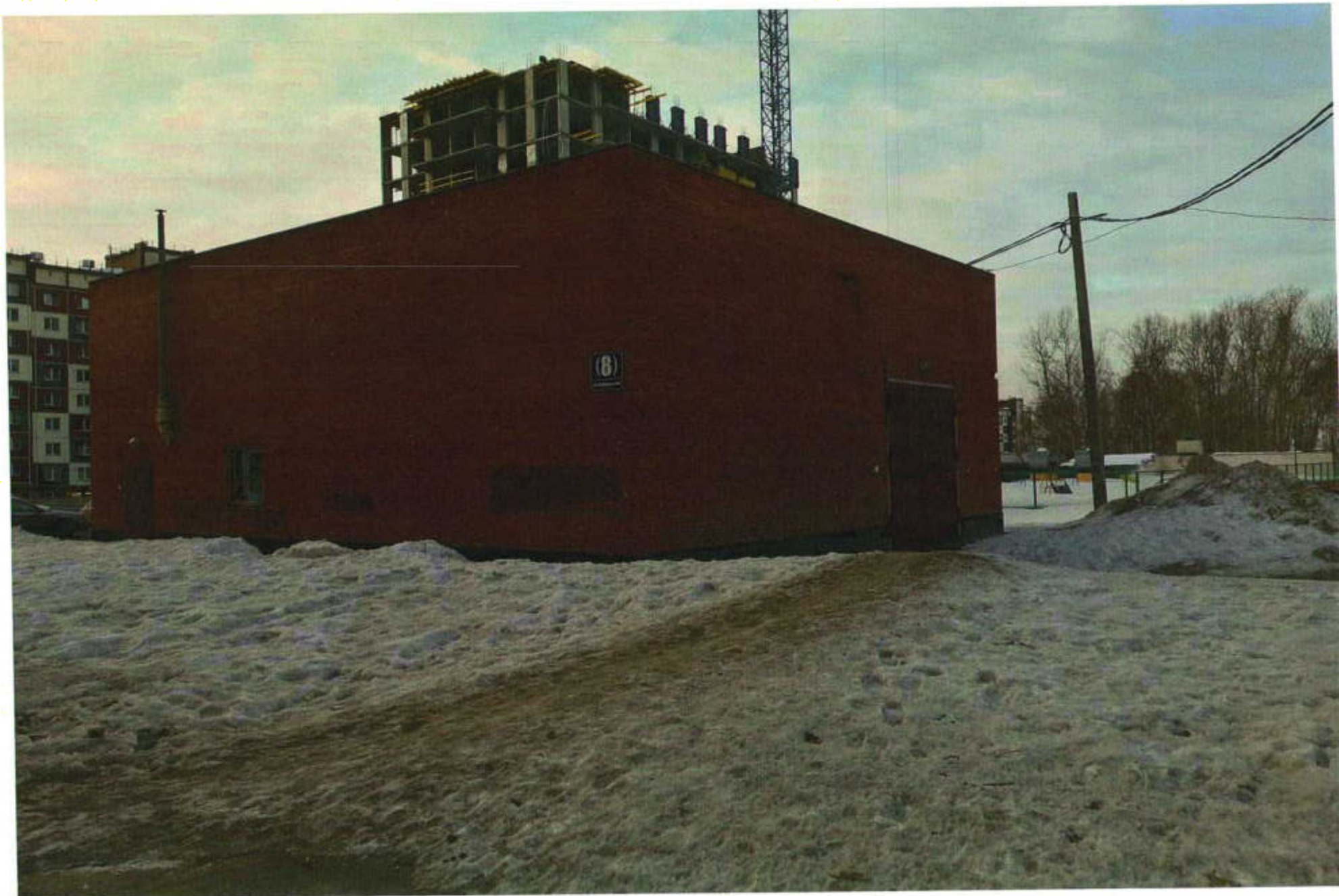
Центральный тепловой пункт (ГНС) по ул. Гребенщикова, 8
