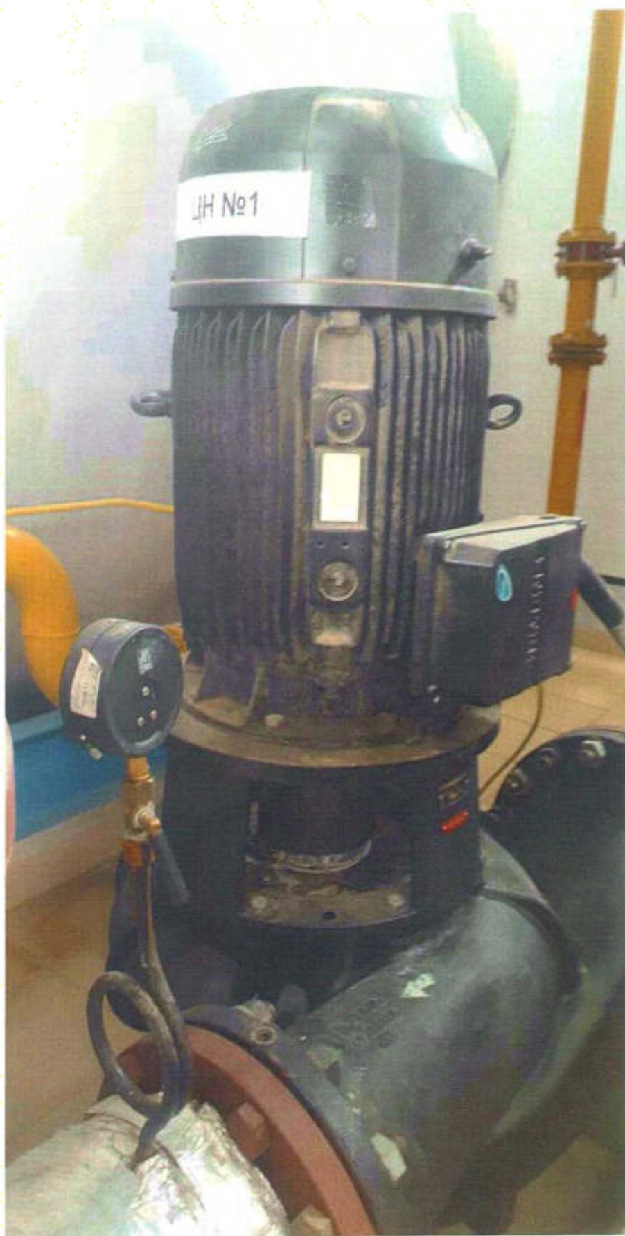
ЦИРКУЛЯЦИОННЫЙ НАСОС Siemens Grundfos TP200-270/4
