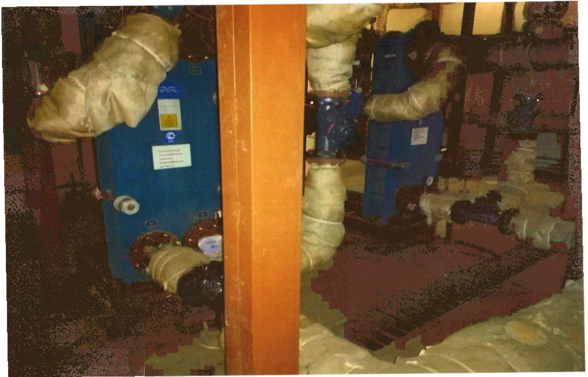
Теплообменник ГВС, 2-я ступень, пластинчатый M15-BFG, Альфа-лаваль
